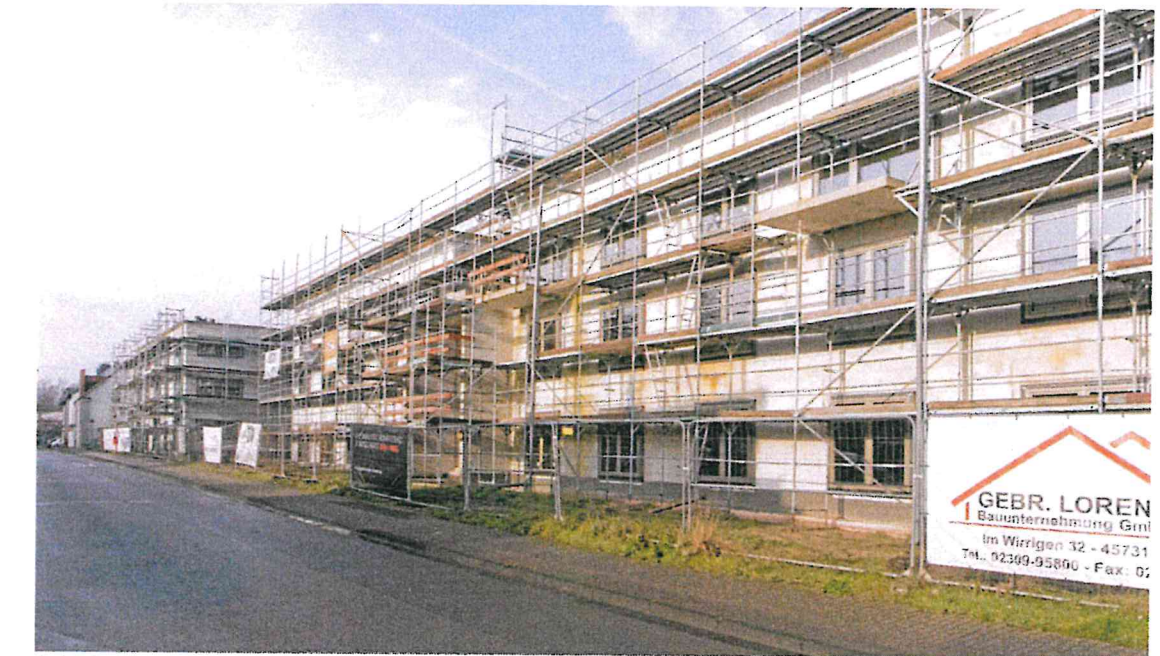
Rechts im Bild befindet sich das Hauptgebäude mit einer geplanten Kurzzeitpflege und Wohngemeinschaften für Menschen mit Demenz. Links (weiter hinten) an der Lehmkuhler Straße ist das zweite Gebäude im Bau zu sehen. Dort entstehen Appartements und Zwei-Raum-Wohnungen.
